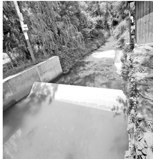
一道闸坝将南冲河(高新区段)河道一分为二:一边是浑浊的农业面源污染水体,一边是清澈见底可直排滇池的净化水。
