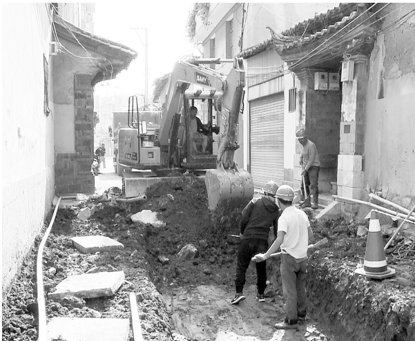
通海县城老城区雨污分流改造
