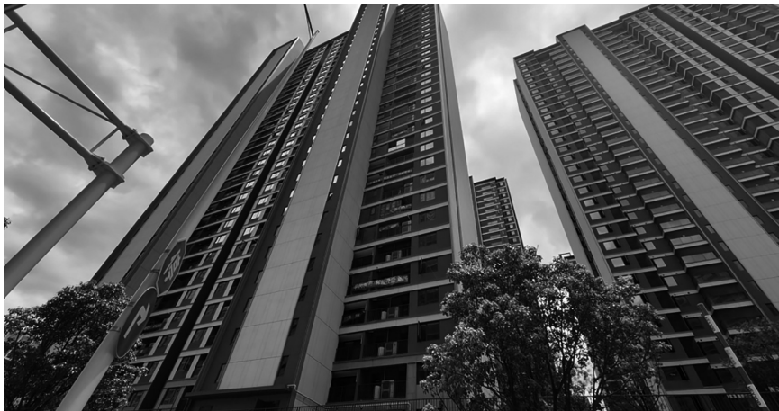
被切割横梁的涉事楼栋 图据澎湃新闻
