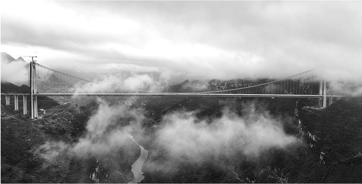
大桥为钢桁梁悬索桥,全长2890米,其中主桥跨径1420米,桥面至水面高度625米。 新华社记者 杨文斌 摄
