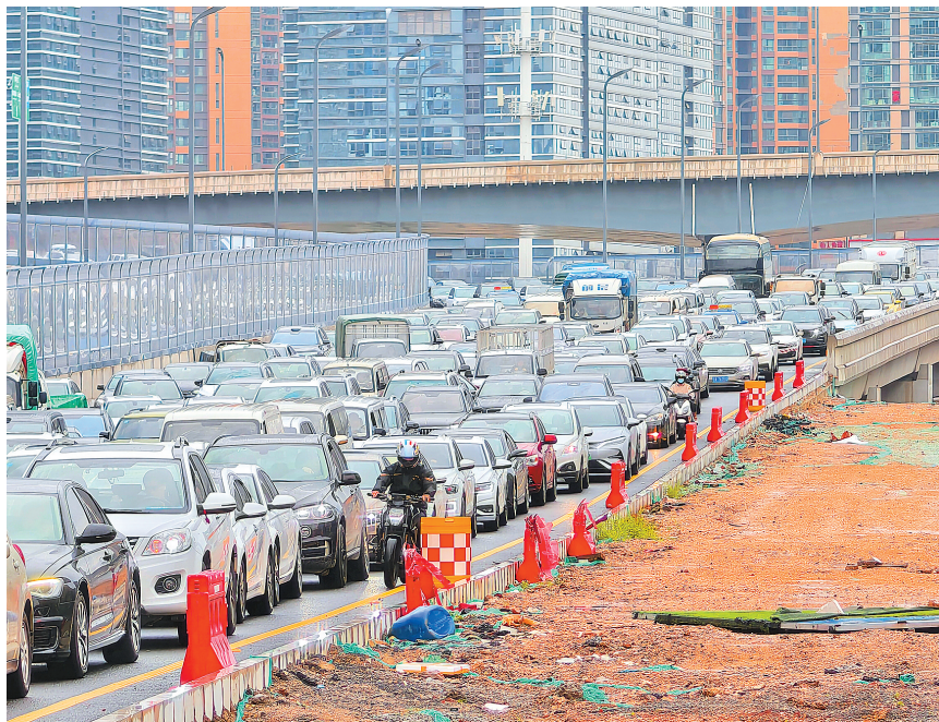
完工后将有效缓解交通拥堵
