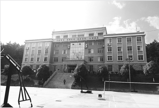
煤矿办公大楼
