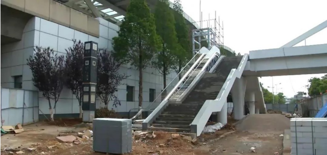
斗南站人行天桥已经基本建成
