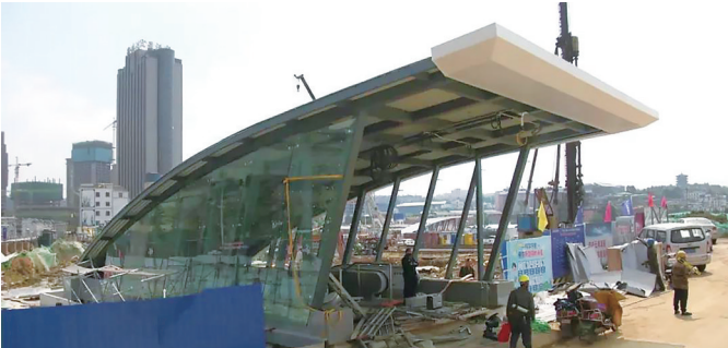
金桂街站站口外观基本完工
