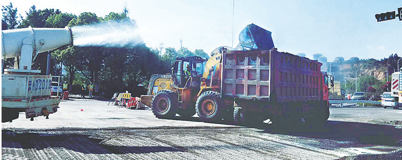
定时对施工现场洒水避免扬尘
