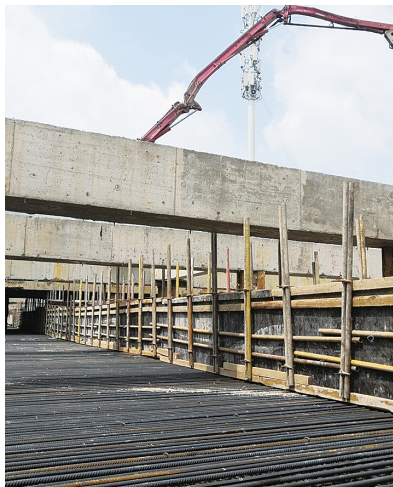
世博园站主体结构八单元顶板混凝土浇筑
