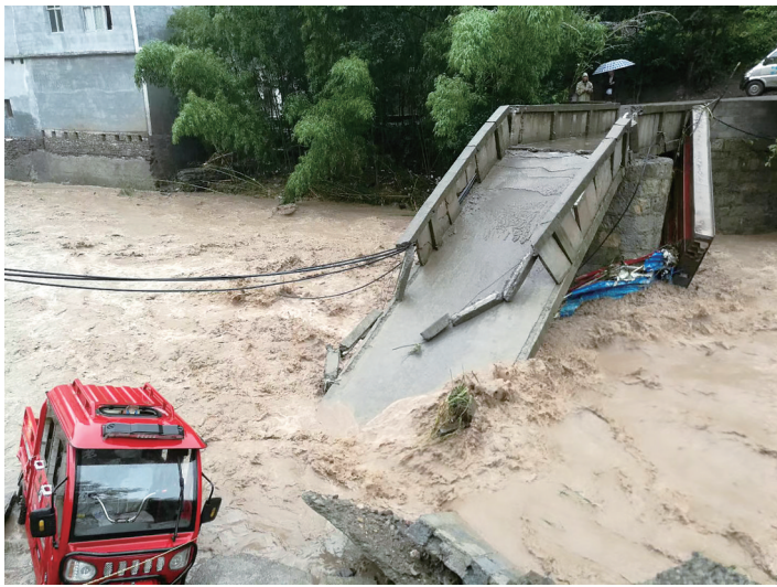
洛旺乡一处桥梁被冲毁,大货车被淹。
