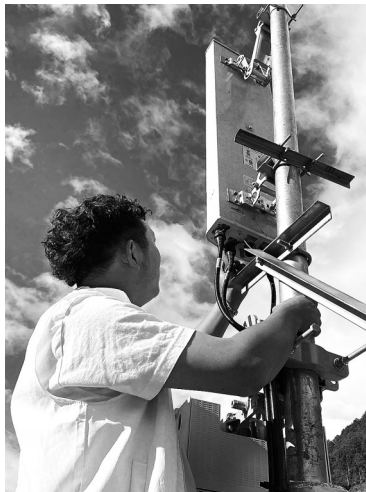
云南电信工程师正在迪庆州德钦县燕门乡5G基站调试 云南电信供图
