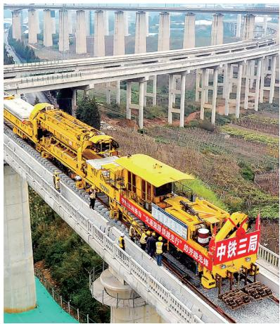
12月10日上午,弥(勒)蒙(自)高速铁路明以则大桥施工现场机器轰鸣,随着现场指挥员下令“开始铺轨”,一台TCM60型长钢轨铺轨机将一对500米长钢轨稳稳地落槽就位,标志着弥蒙高铁全线铺轨正式拉开序幕。
