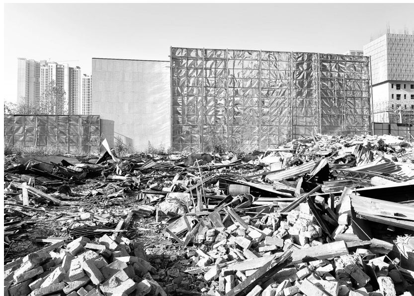
“钉子户”的建(构)筑物被拆除
