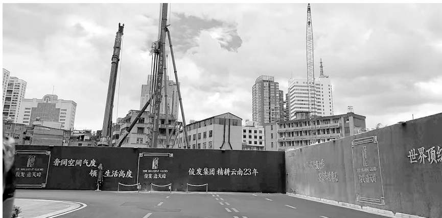
昆纺白塔路片区旧城改建项目地块用围挡隔离，内竖有桩基。
