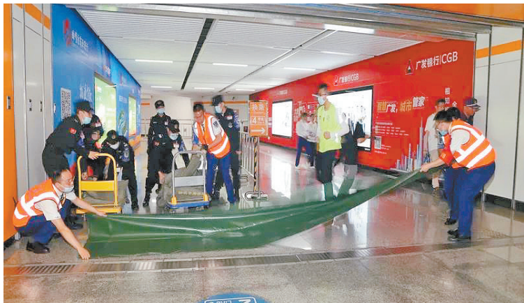
迅速采取防汛挡板安装、沙袋加固、人员疏散、地铁停运、轨道断电等措施
