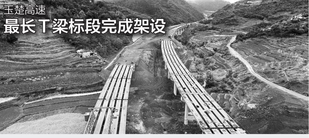
本报讯 (通讯员 翟朝晖 李欢 何增旺) 3月23日，随着最后一片T梁在各三郎1号大桥平稳落下，中铁五局承建的玉楚高速公路项目TJ-14标段圆满完成2578片预制T梁架设任务，该标段是玉楚高速全线T梁架设总量最长，任务最重的标段。该标段的顺利完工，为确保玉楚高速实现年中通车目标形成有力保障。
