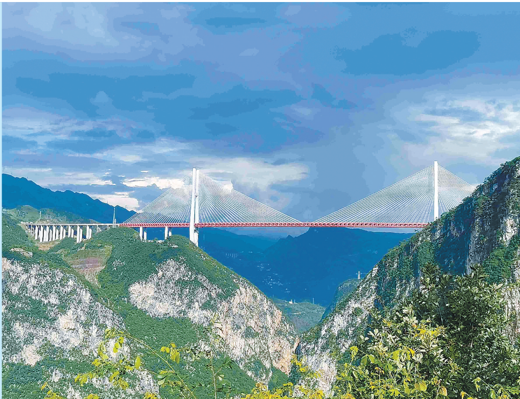
横跨尼珠河大峡谷之上,大桥全长1341.4米,主跨720米,桥面高565.4米(相当于200层楼的高度),为世界最高的大桥。
