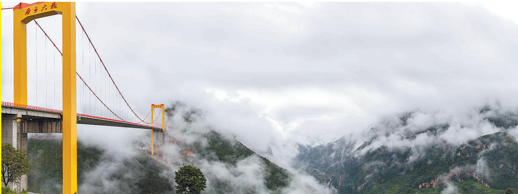
全桥长1040米,主跨628米,桥面高500米,是世界最高的悬索桥。
