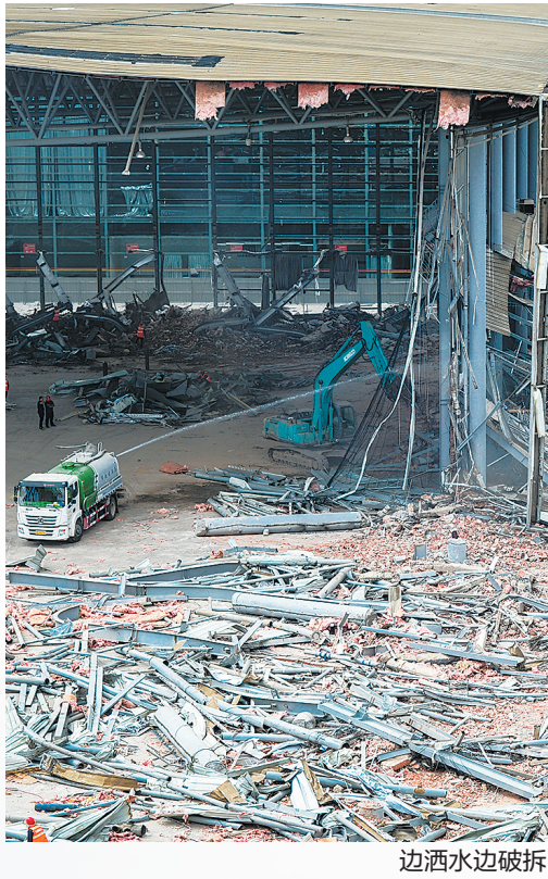
边洒水边破拆
