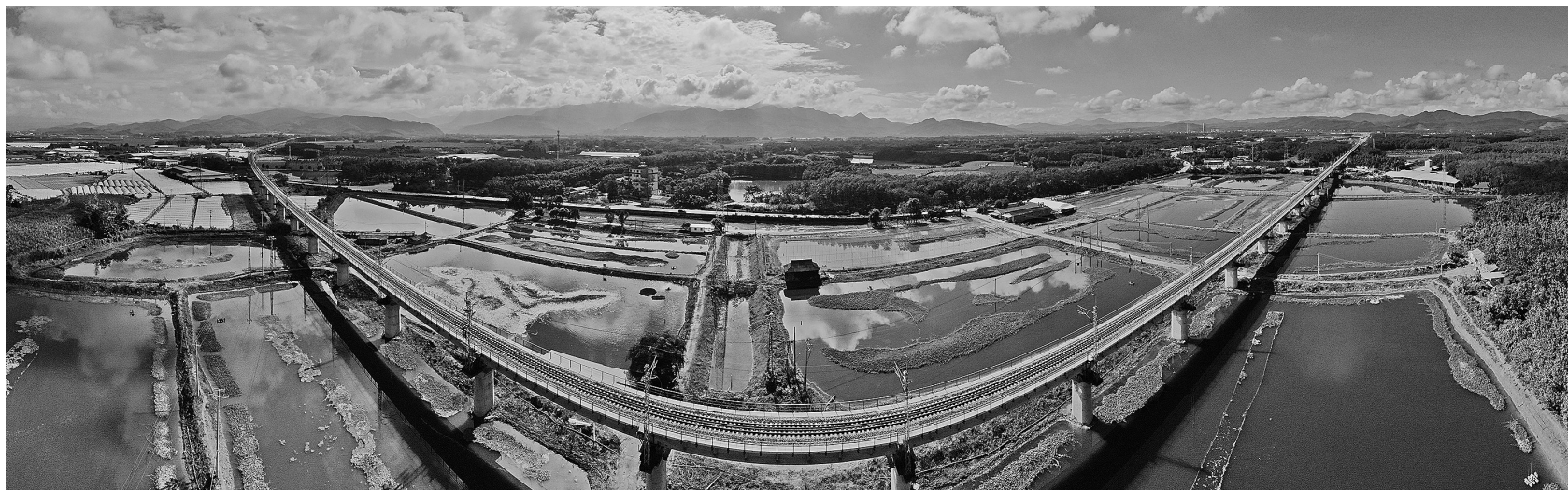
位于云南景洪市境内的中老铁路橄榄坝特大桥 新华社发 李云生 摄
