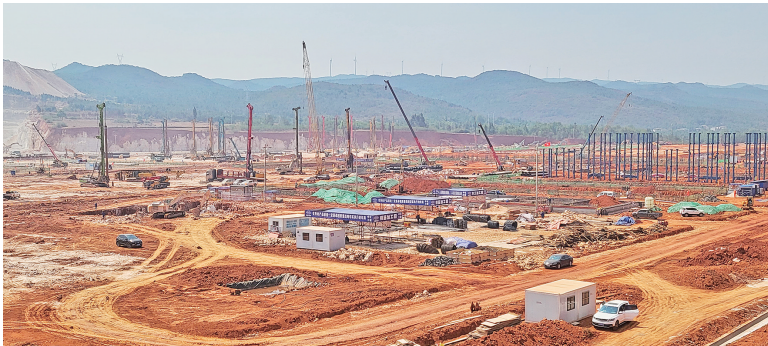
麒麟区产业园区信義玻璃施工现场
