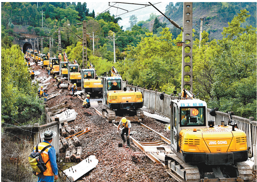
对南昆铁路进行轨枕更换 通讯员 多恒锐 摄
