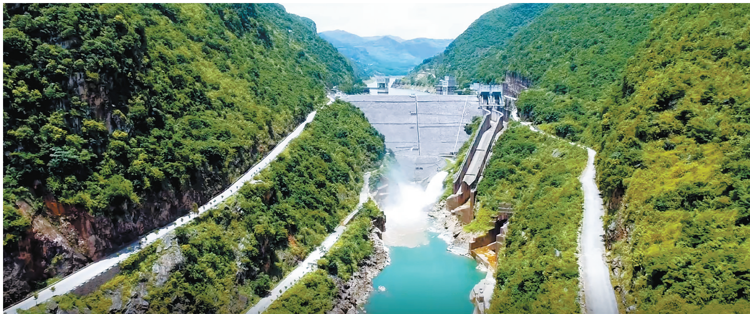
鲁布革水电站大坝 侯海琳 摄
