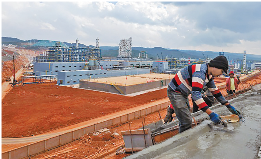
曲靖市麒麟产业园区的信义集团硅光伏项目正在抓紧建设中,一期项目计划今年3月投入试生产。 新华社记者 浦超 摄
