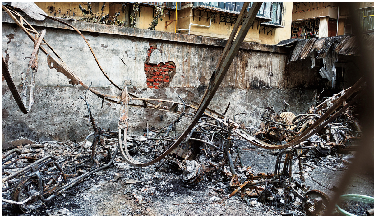
失火的停车棚棚顶已经坍塌
