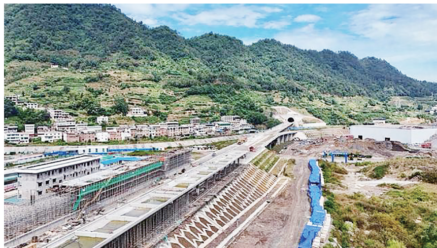
渝昆高铁川滇段完成架梁
