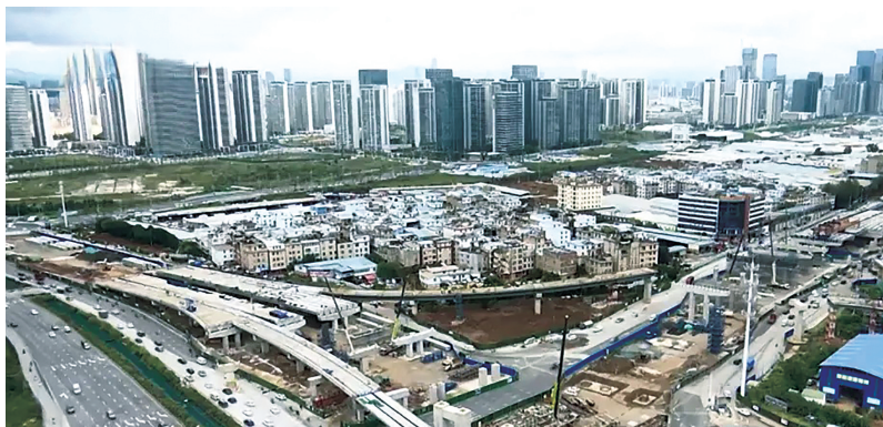
建设中的广昌立交桥
