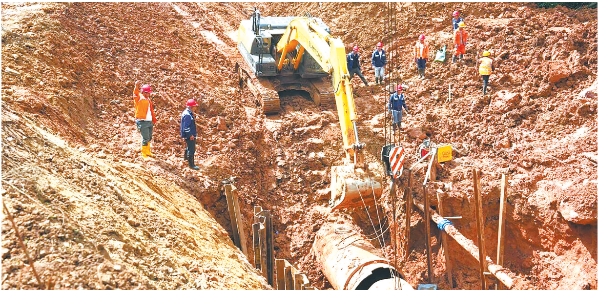
图片源自昆明水务集团微信公众号 施工人员对破损管道进行抢修
