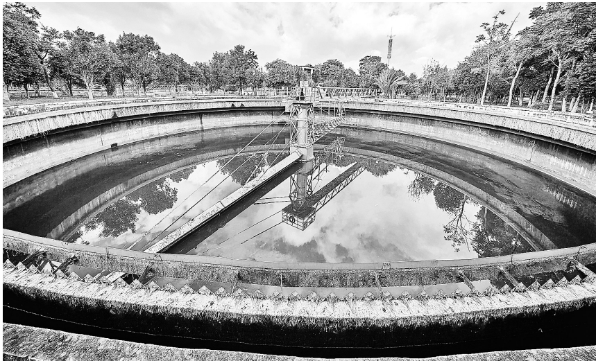
今年10月,昆明第七、八水质净化厂二沉池完成更换吸刮泥机。
