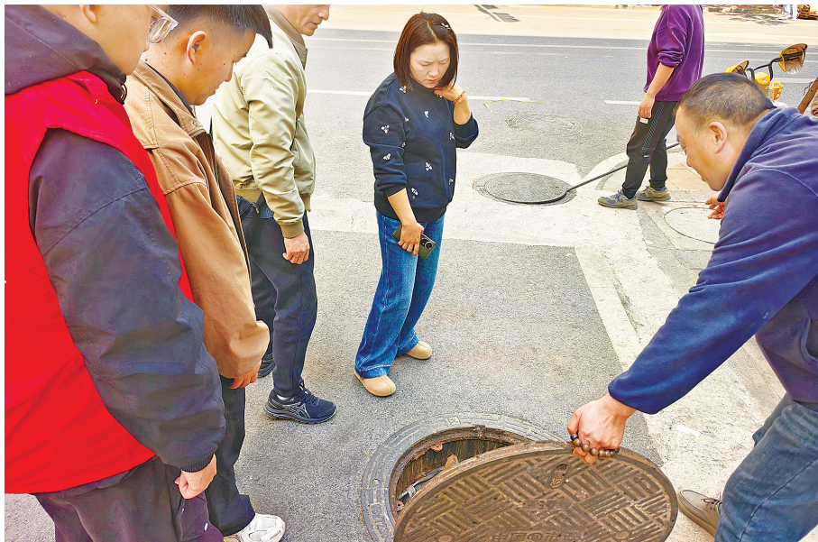
丰宁街道办和虹山东路社区工作人员监督施工方查找污水淹积的原因
