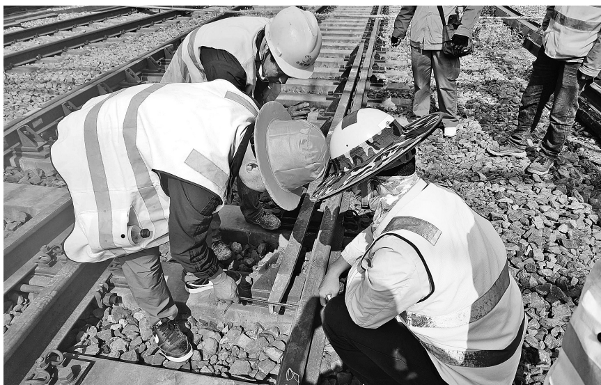
铁路线范围内施工
