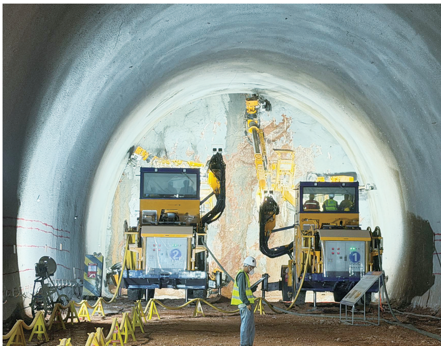
工人正在操作大型智能机械进行施工
