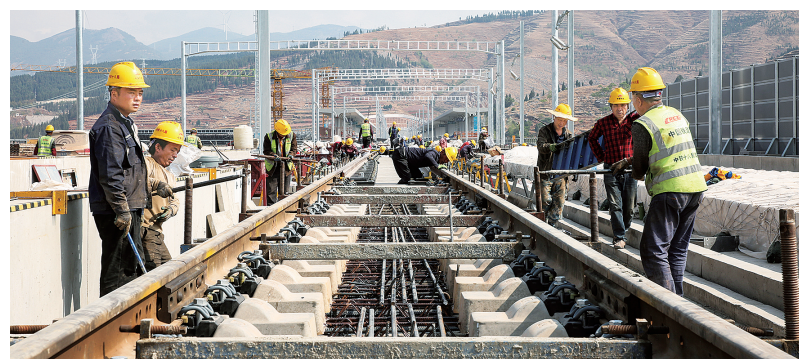
施工人员正在铺轨
