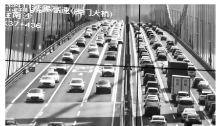
虎门大桥桥面在5日下午出现较大幅度振动时,桥上车水马龙,车主表示能明显感觉到不适。
