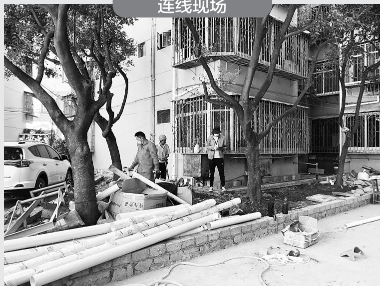
涉及院内花台修补、装饰,室外污水管道疏通等项目。
